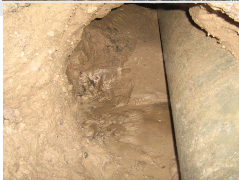
Foto: Lekkage/breuk in leidingwerk.
