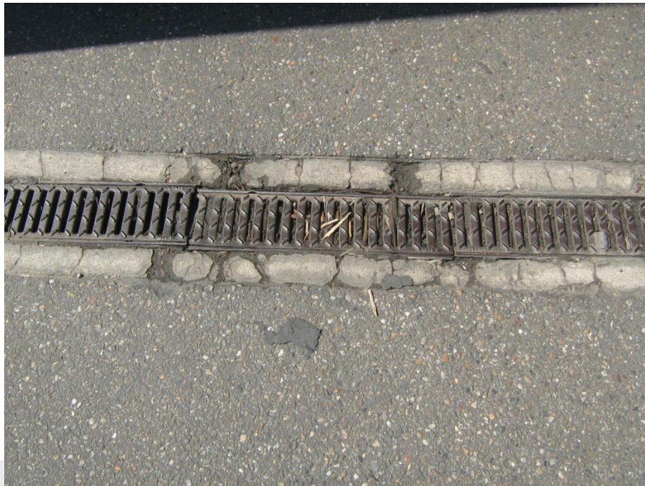
Foto: Aansluiting op lijngoot.
