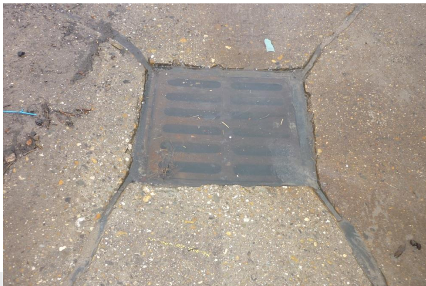
Foto: Ontvangpunt tot bovenzijde gevuld met water.
